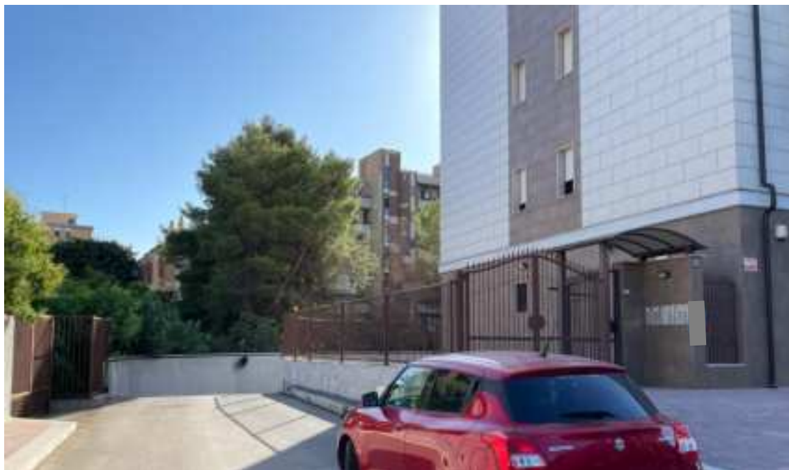
Foto 2_Rampa di accesso ai box su via Cappuccini
