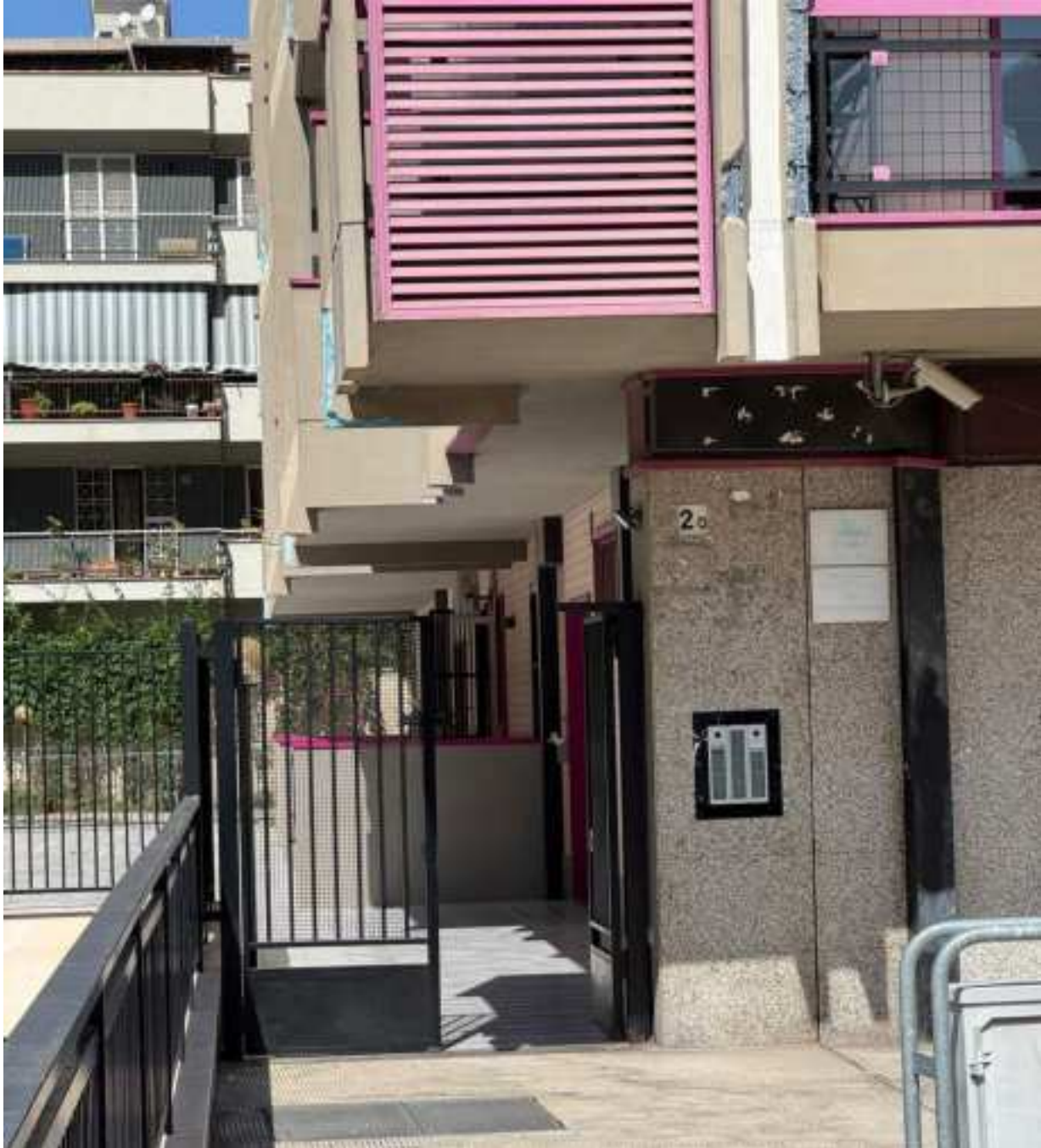
Foto 3_Ingresso agli appartamenti/uffici su via Napoli
