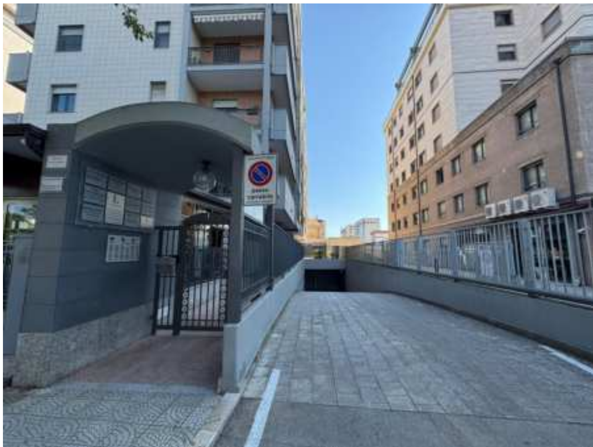
Foto 2 Rampa di accesso ai box interrati su via Gramsci
