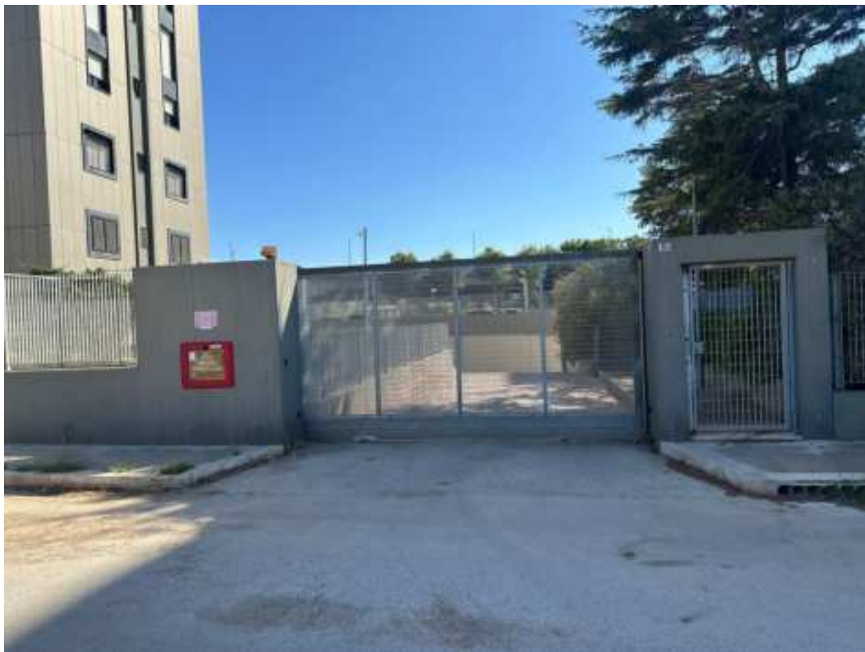
Foto 1 _Ingresso ai box interrati in via Tenente Suglia
