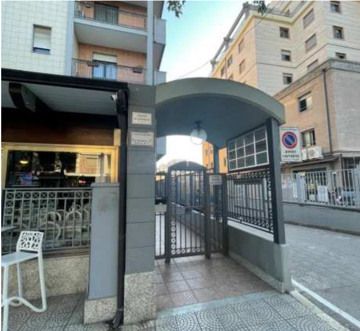
Foto 1 Ingresso agli appartamenti (scala A-B-C) su via Gramsci
