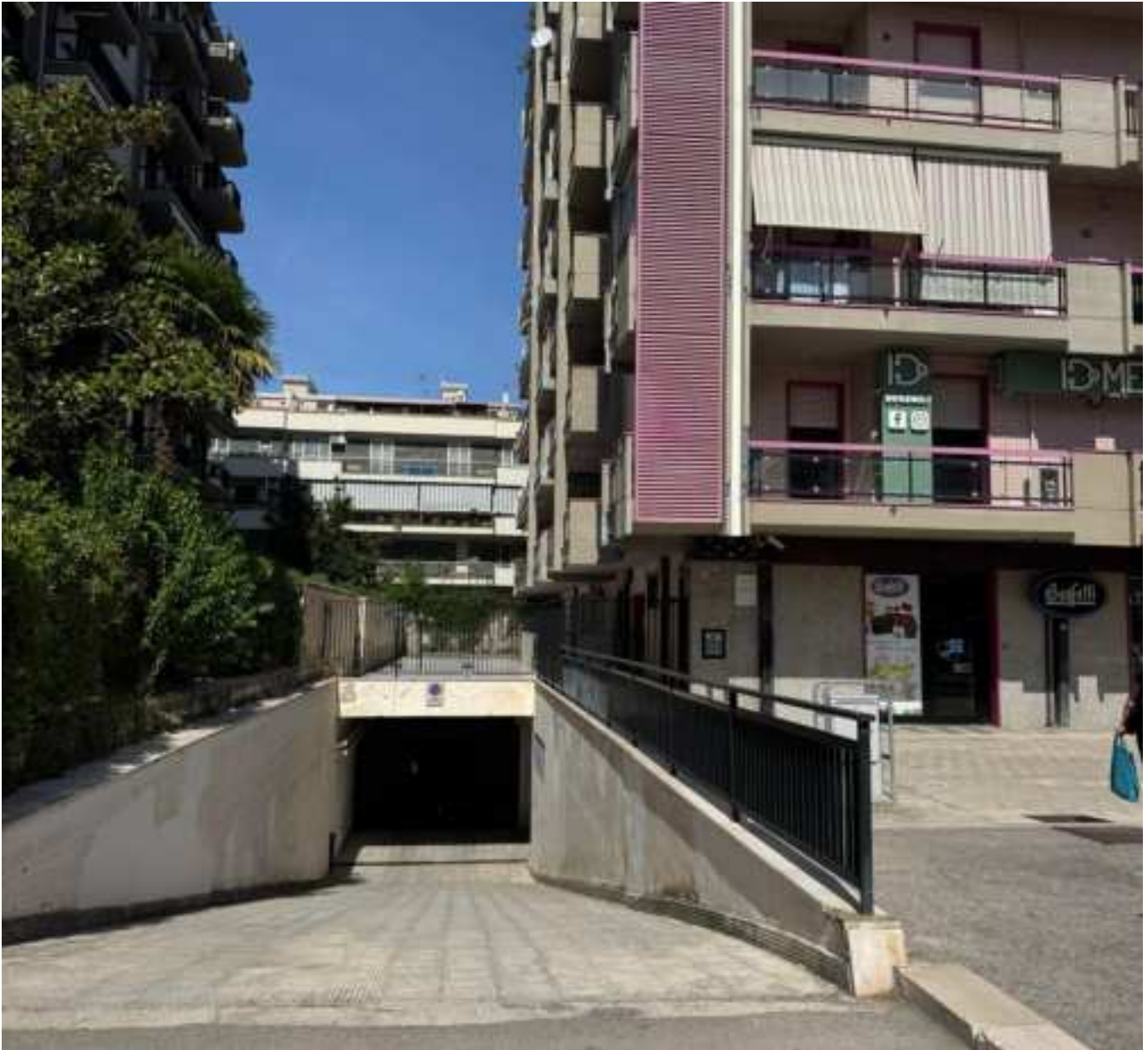
Foto 1 Ingresso ai box, ai locali interrati e agli appartamenti/uffici su via Napoli
