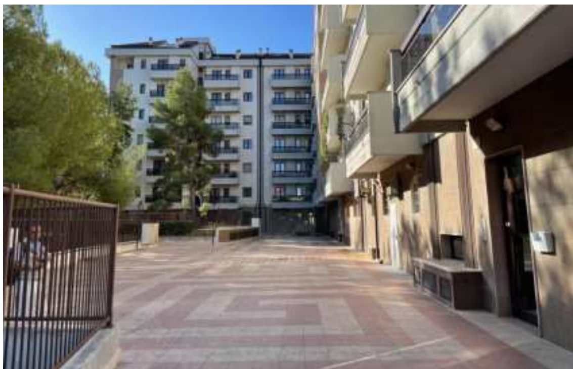
Foto 4_Cortile di ingresso agli appartamenti (scala A-B-C-D) su via Cappuccini
