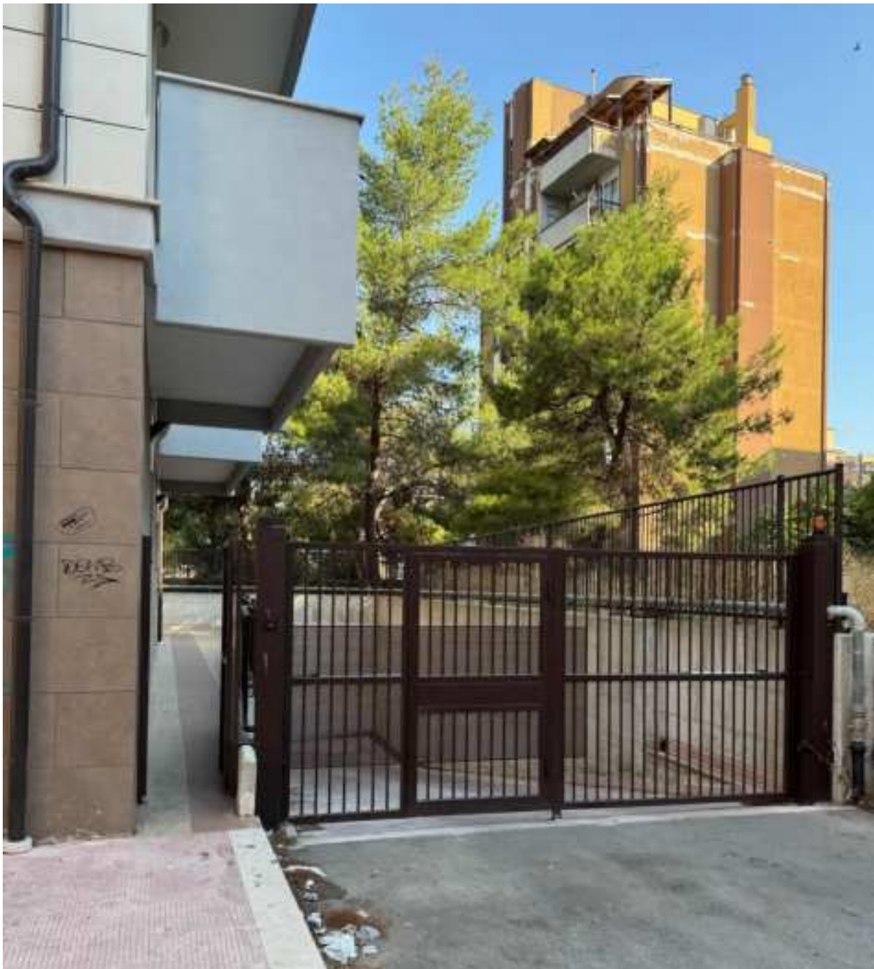
Foto 6_Ingresso ai box interrati e agli appartamenti (scala A-B-C-D) su vicolo dei Cappuccini
